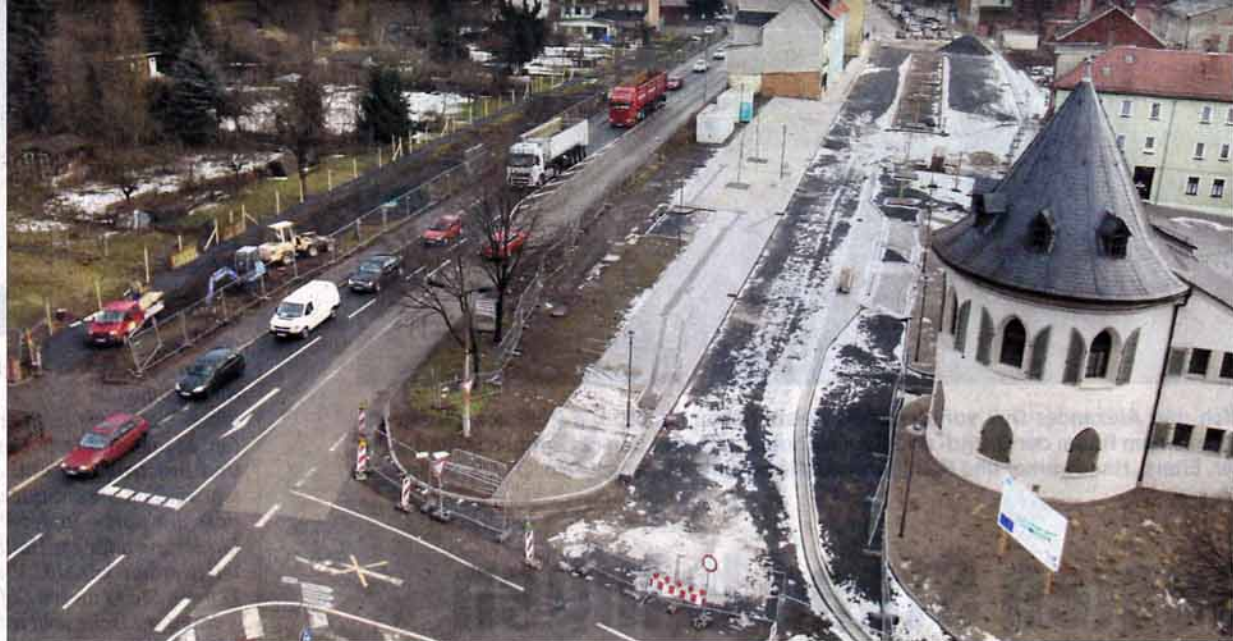
Blick auf die Ernst-Thälmann-Straße mit der B 281 sowie auf die Gerberstraße mit dem Busbahnhof in Pöbneck: Ab Ende März wird die Bundesstraße für die jahrhunderthochwassersichere Neuverrohrung der darunter fließenden Kotschau aufgerissen. Fast gleichzeitig beginnt die letzte Phase der Bauarbeiten am neuen ÖPNV-Gelände. (Foto: OTZ/Marius Koity)
