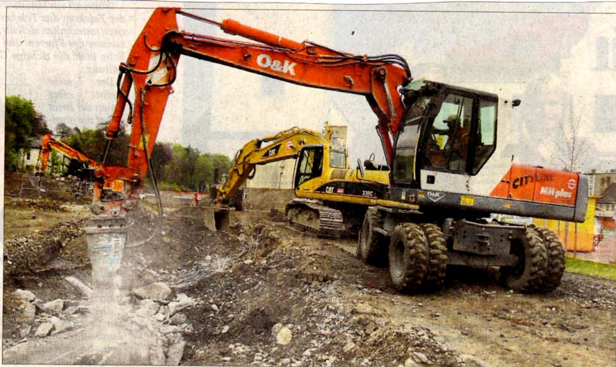
Der legendäre Pöbnecker „Fresswürfel“ lässt grüßen: Fundamente der einstigen Rotasym-Kantine, die auf der Baustelle der B 281 neuen Leitungsschächten im Wege standen, wurden dieser Tage weggepickert. (Foto: OTZ/Marius Koity)
